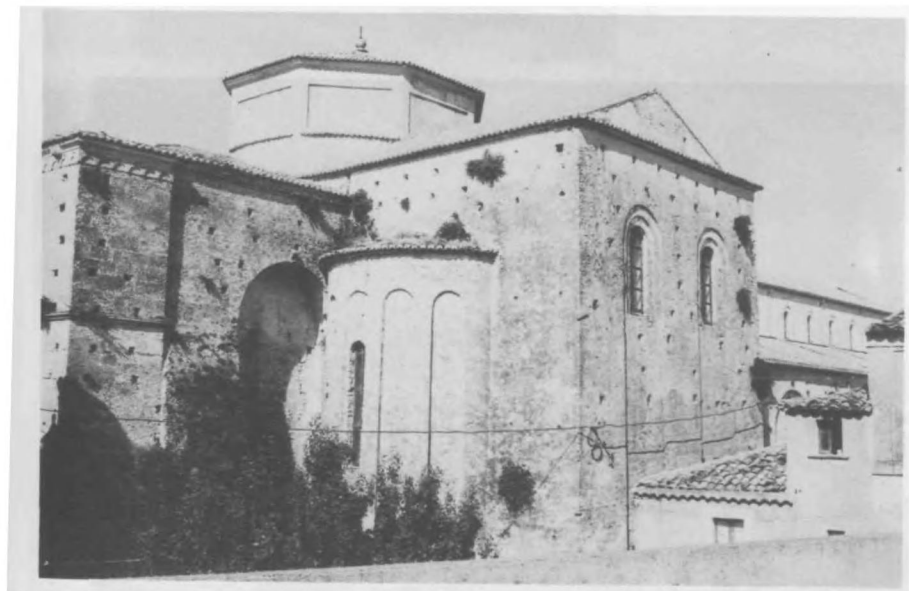
Foto. 6. — Gerace, cattedrale. Abside e testata nord.
